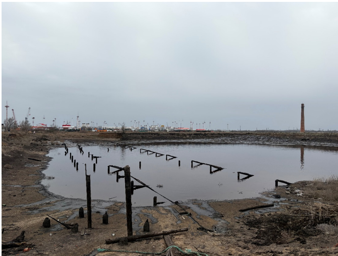
Рис. 1. Один из открытых котлованов Ильинских нефтям с видимой жидкой поверхностью на момент обследования
