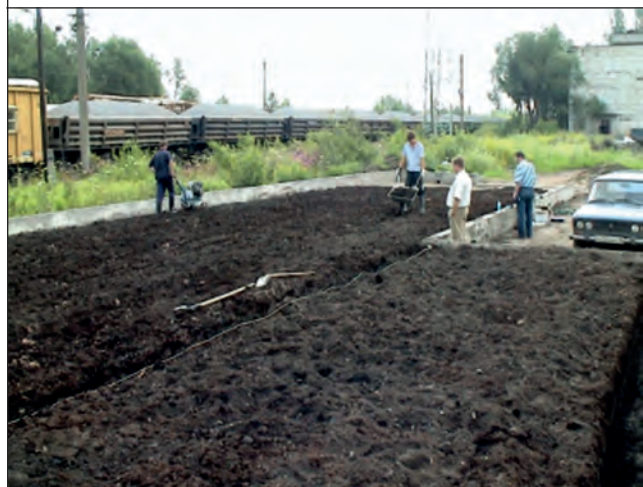
Рис. 17. Регламентные работы по биокомпостированию
