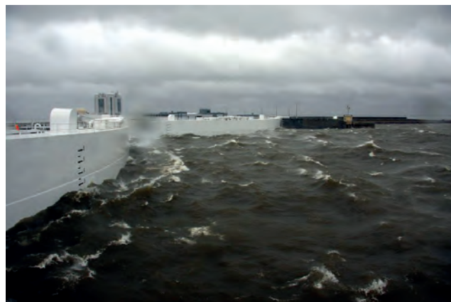
Рис. 15. Судопропускное сооружение С1 во время наводнения 26–28 декабря 2011 г.
